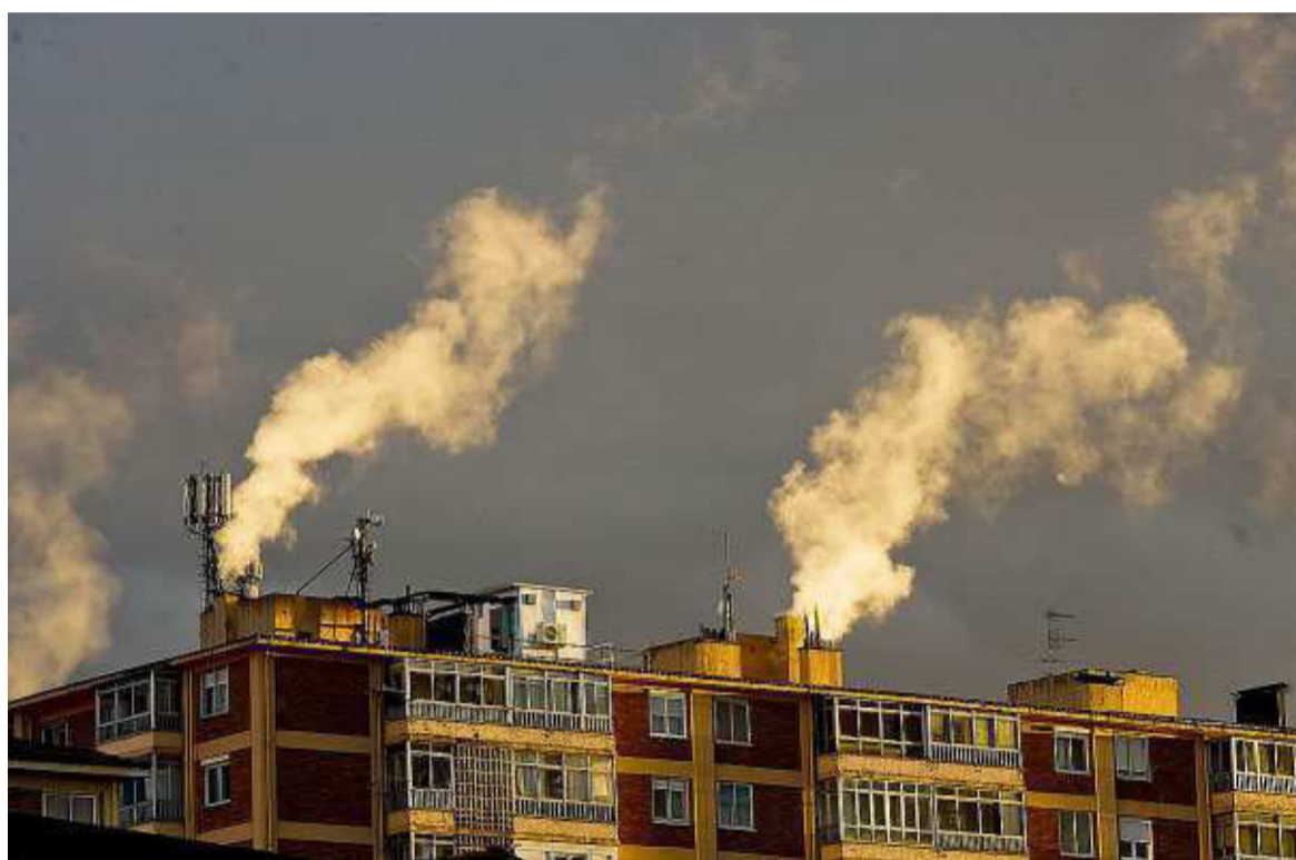
Varios edificios expulsan humo de las calefacciones por sus chimeneas. / ALBERTO RODRIGO
